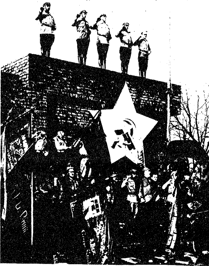
202. Rooftopfront am Denkmal Raim Luxemburgs und Karl Liebknechts
